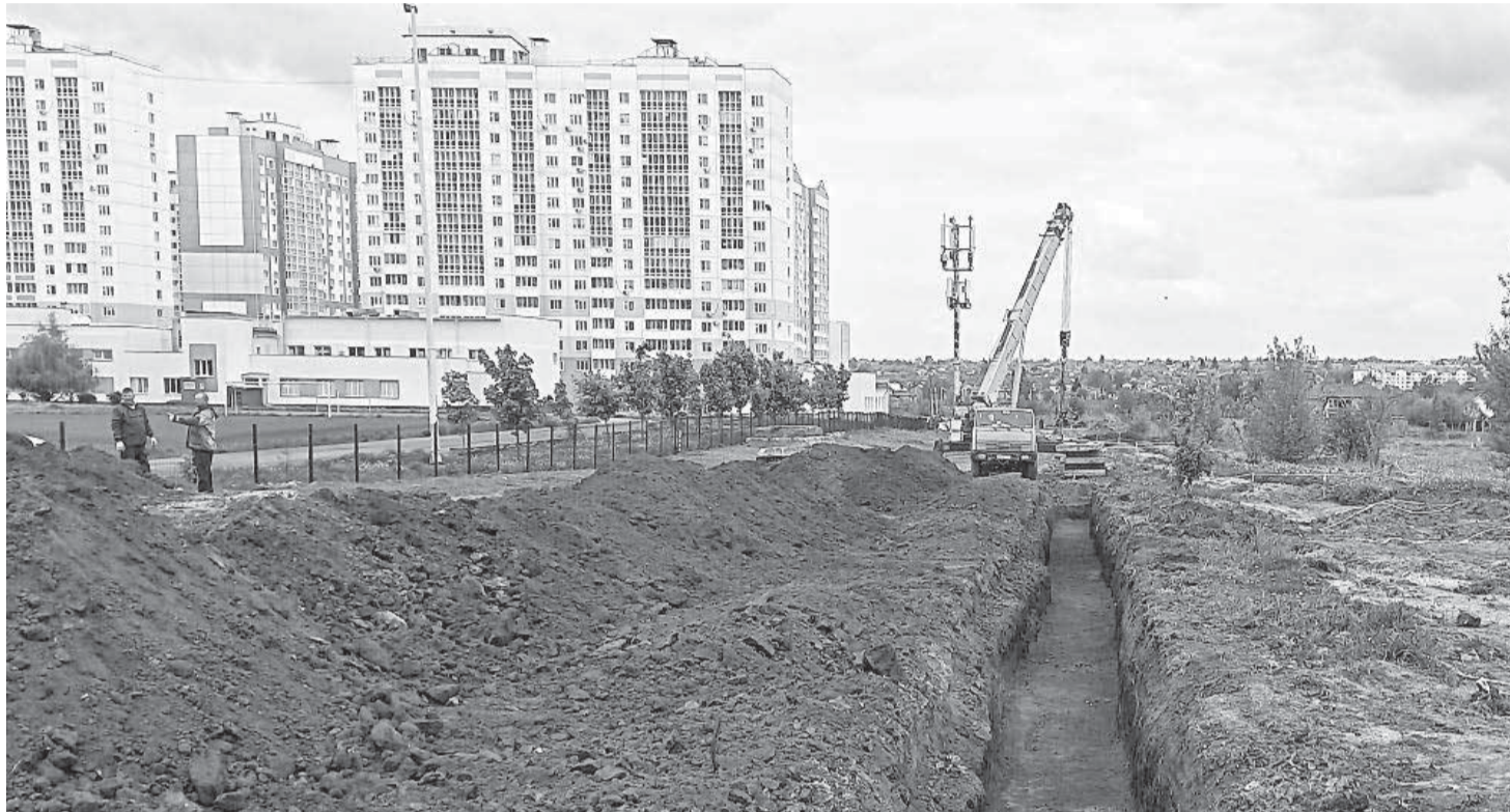
ФОТО ДЕПАРТАМЕНТА ДОРОЖНОГО ХОЗЯЙСТВА, ТРАНСПОРТА И РЕАЛИЗАЦИИ ГОСУДАРСТВЕННЫХ СТРОИТЕЛЬНЫХ ПРОГРАММ ОРЛОВСКОЙ ОБЛАСТИ
