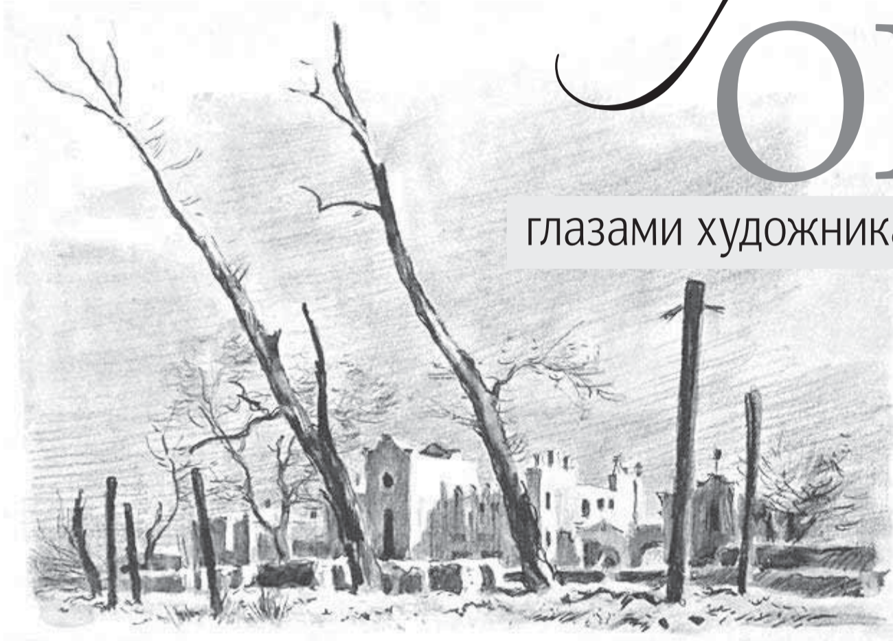
РАЗРУШЕННОЕ НЕМЦАМИ ЗДАНИЕ ВОКЗАЛА В ОРЛЕ
