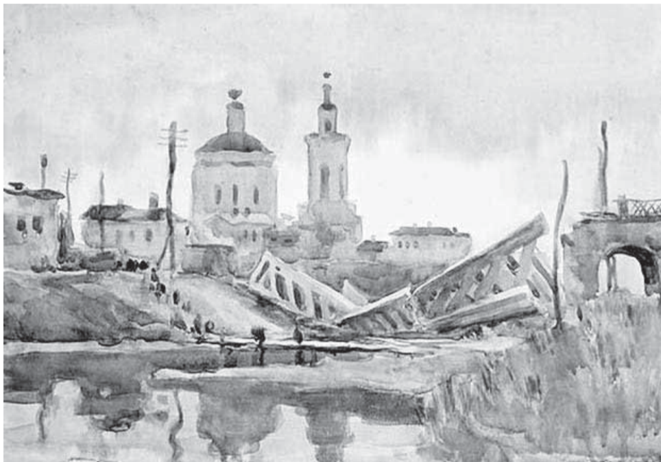
РАЗРУШЕННЫЙ МОСТ ЧЕРЕЗ РЕКУ ОРЛИК. ОКТЯБРЬ (1943).
